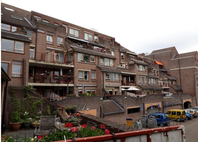
Foto: Complex Fregat
